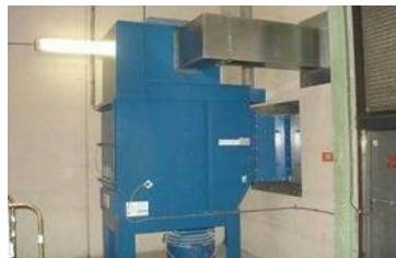
Centraal ontluchtingsfilter (zuigend)
