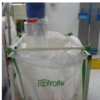
Big Bag onder filterinstallatie
