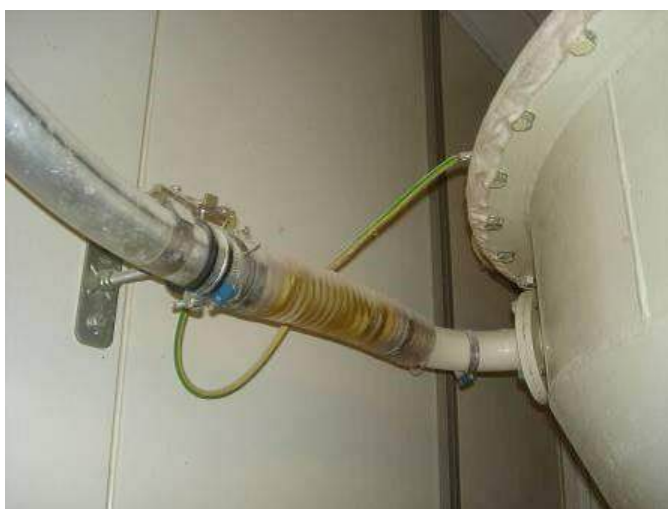
Flexibele koppeling (aansluiting weegbunker) 1 uiteinde flexibel niet geaard
